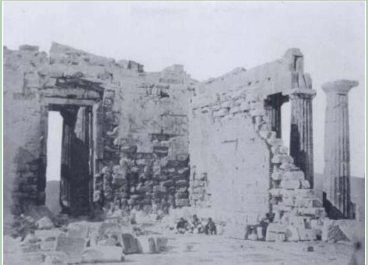
Atene, Benaki Museum. Interno della cella del Partenone vista da sud-est, blocchi del fregio allineati lungo un muro in mattoni moderno, stampa all'albumina di J. Robertson (1853-4).
